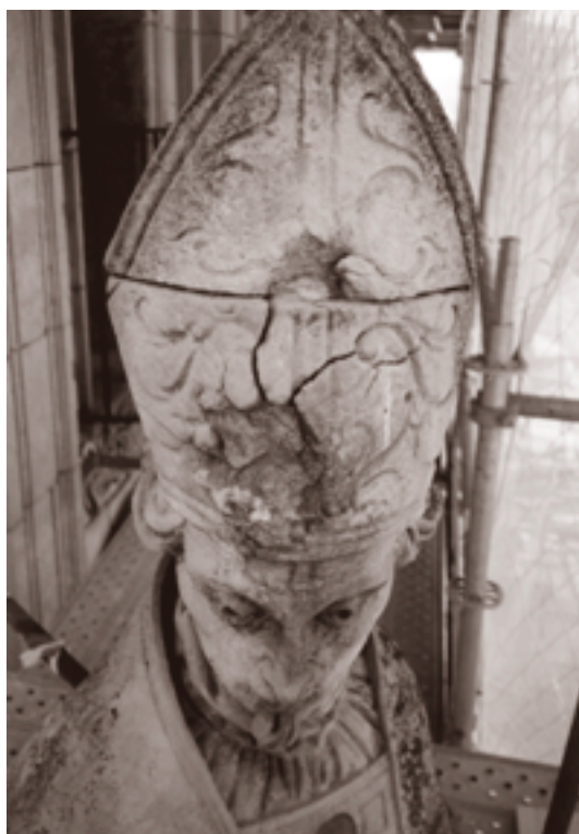
ANTERIOR A LA INTERVENCIÓN
