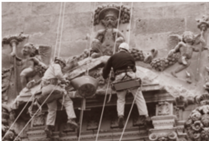
DURANTE LA INTERVENCIÓN
