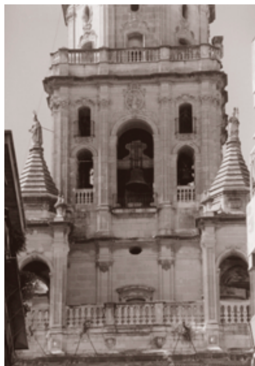
ANTERIOR A LA INTERVENCIÓN
