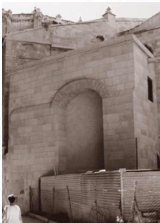
ANTERIOR A LA INTERVENCIÓN
