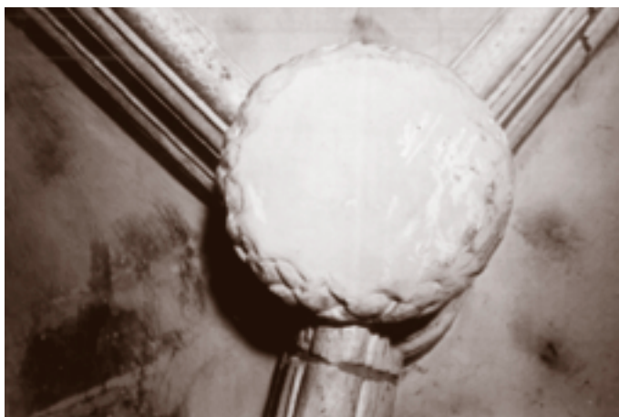
ANTERIOR A LA INTERVENCIÓN
