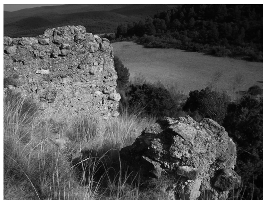
Lámina 5. Reparación y recrecimientos de los alzados de la fortificación.
