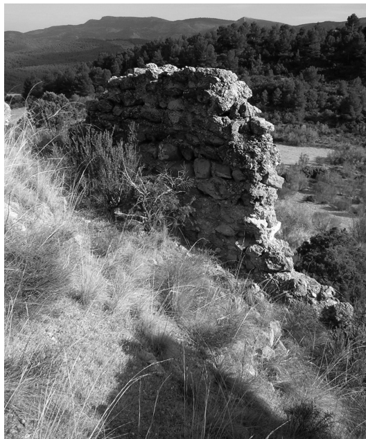
Lámina 4. Reparación y recrecimientos de los alzados de la fortificación.
