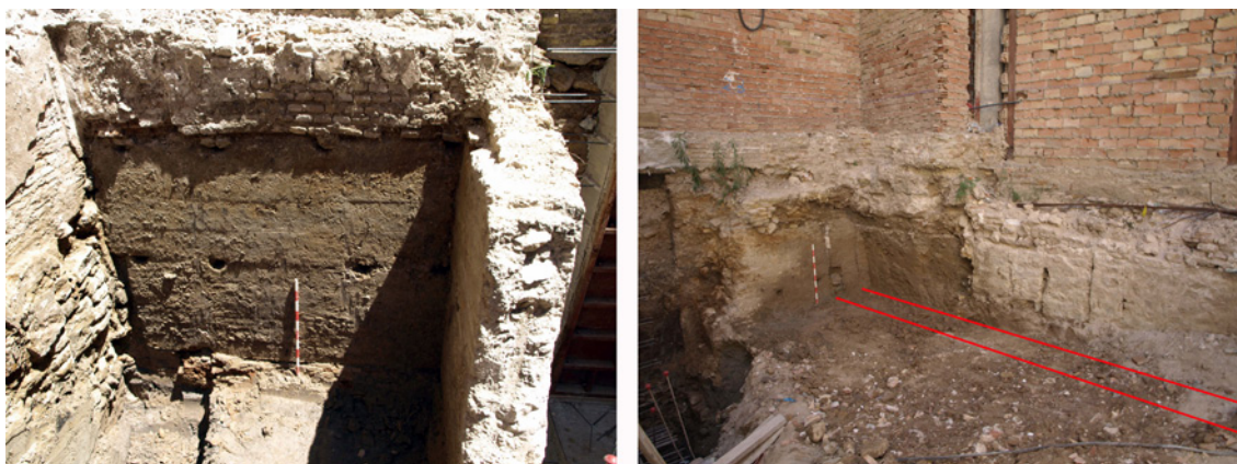
Lámina 10. Vista del límite oriental de la vivienda I. Obsérvese como en la lámina de la izquierda la obra de tapial se adosa a una fábrica preexistente, interpretada como el muro de cierre del huerto por su lado septentrional. En la lámina de la derecha la obra de tapial se adosa a una fábrica preexistente en este caso de tierra, interpretada como el muro de cierre del huerto por su lado meridional.
