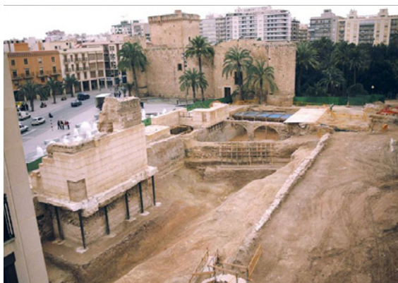
Lámina 2.- Excavaciones en el foso y muralla de traspalacio de Elche (Fotografía empresa Alebus).
