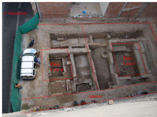
Lámina 11. Vista cenital del solar donde quedan marcados los límites de las viviendas y la ubicación del adarve.
