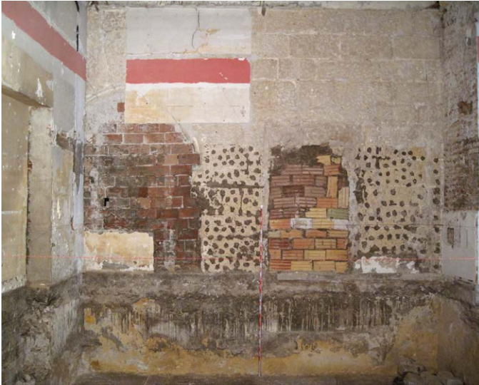
Lámina 3. Lateral norte de la sala capitular. Puerta original y ventana oeste.
