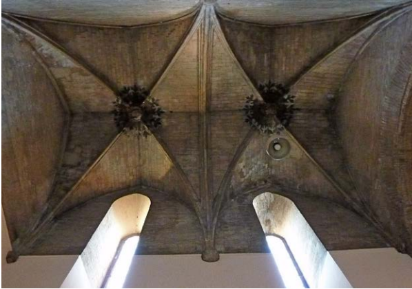
Parroquieta. Exterior e interior de las ventanas góticas de la nave
