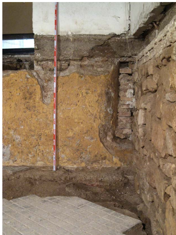
Lámina 8. Al frente, vista desde el interior del hueco, cegado, de la entrada al claustro por su lateral oeste.
