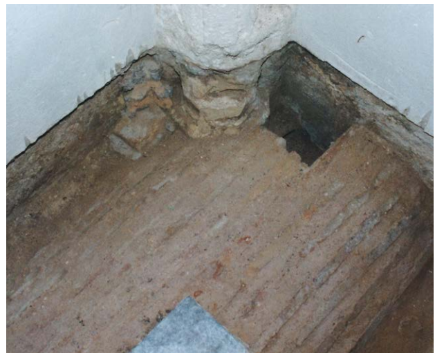
Lámina 5. Sala capitular, rincón noroeste. Bóvedas de la infraestructura de aireación subterránea.
