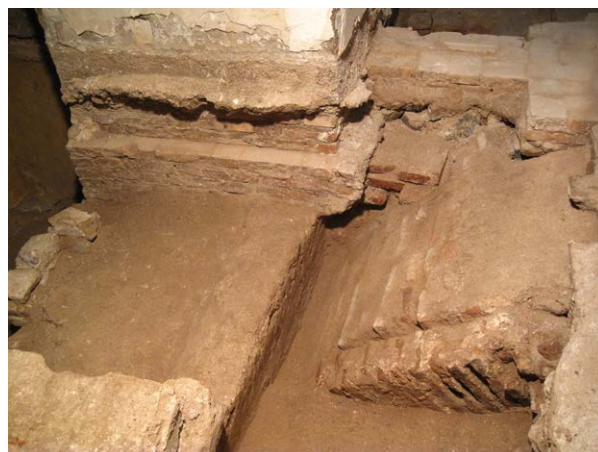
Lámina 1. A la izquierda, tapia de la mezquita; encima, pilar de ladrillo de la década de 1940. A la derecha, bóveda de aljibe.
