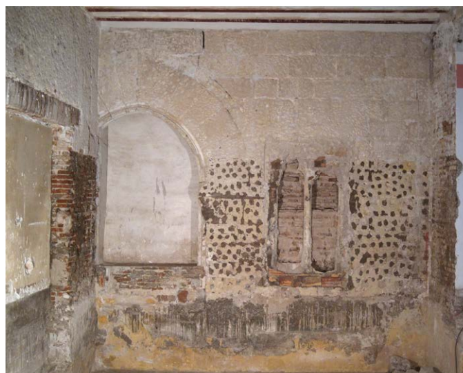
Lámina 2. Lateral norte de la sala capitular. Puerta original y ventana oeste cegadas.
