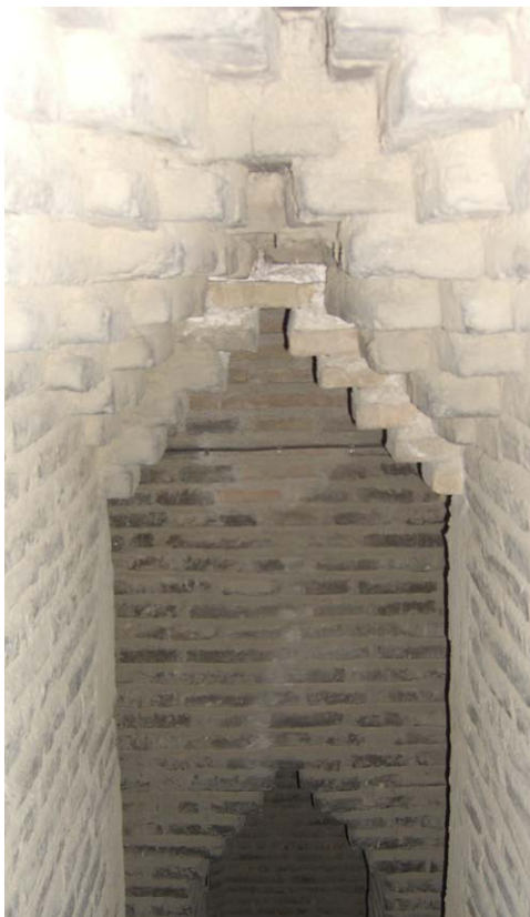
Bovedillas enjarjadas zagríes de la zoma nueva, en el interior del campanario barroco.
