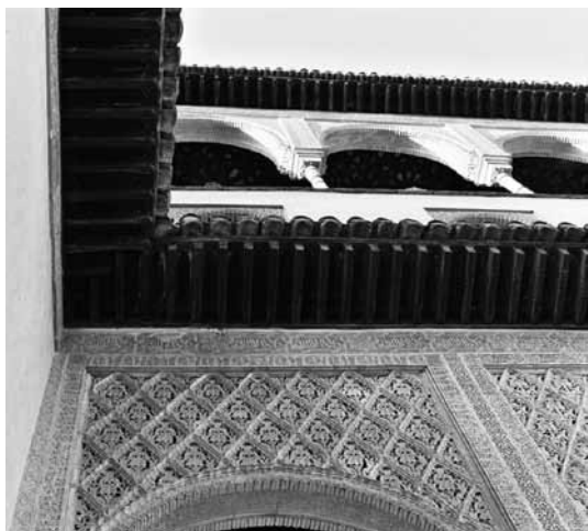
Lámina 4: Alero de patio en esquina. Solución en la esquina sureste del Patio de Comares (s. XIV); superposición de niveles de aleros. Foto: M. Carmen López Pertíñez.
