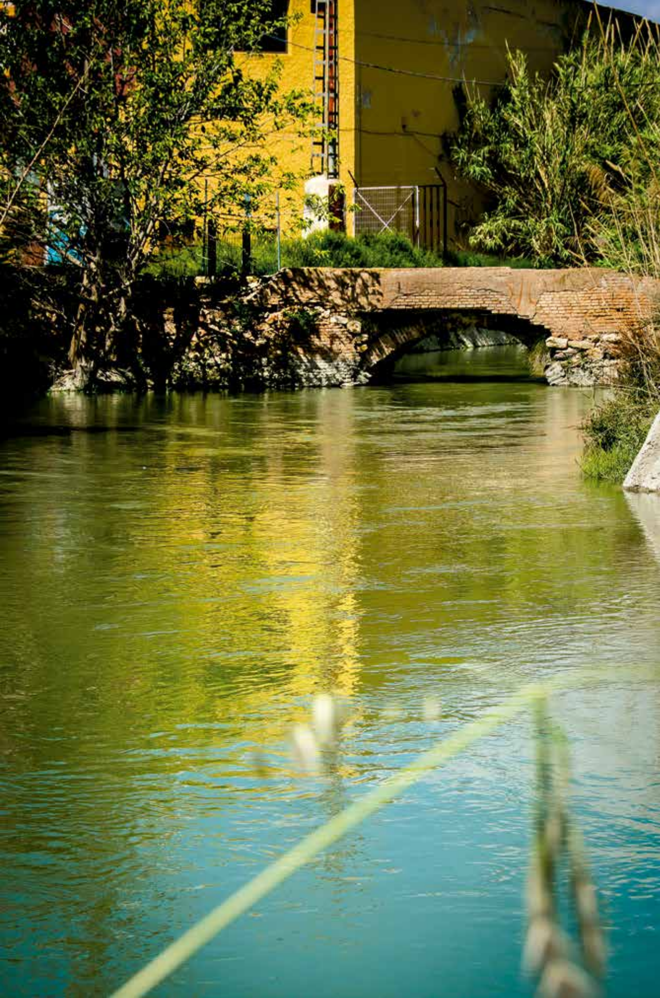
Puente de las Pilas. Alcantarilla
