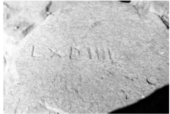
LÁMINA 33 Marca de cantero. LXD IIII.
