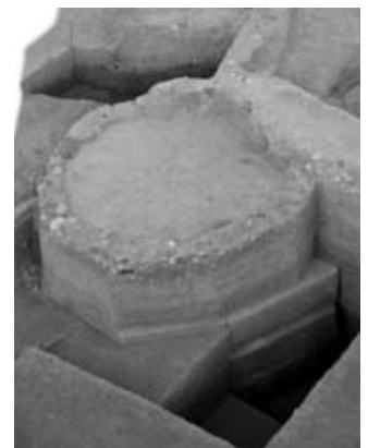
LÁMINA 8 Vista aérea de la torre nonagonal.
