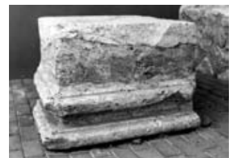
LÁMINA 16 Basa ática de pilastra con imoscapo de fuste tallado en el mismo bloque.
