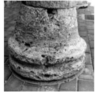
LÁMINA 13 Basa ática con imoscapo de fuste tallado en el mismo bloque.
