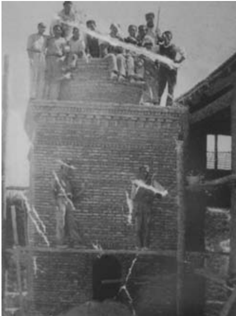
LÁMINA 3 Fotografía de obra, en la chimenea de "Hortícola del Segura" en Las Atalayas en Murcia. Construida por José Pacheco y José Riquelme Almagro. Año 1951. Era normal realizarla cuando se llegaba a este punto de la construcción. Cascales, 2001.
