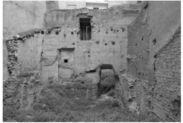
LÁMINA 5 Alzado de la muralla conservado en un solar entre las calles Honda y Pensionista.
