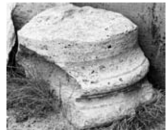
LÁMINA 15 Basa ática sin plinto y con imoscapo de fuste tallado sobre el mismo bloque.
